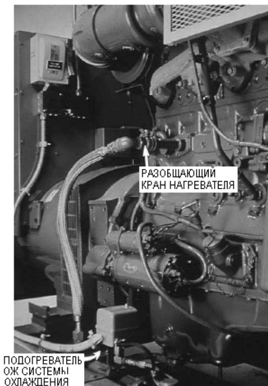
Рис. 4-21. Установка нагревателя ОЖ в рубашке охлаждения двигателя. Не забывайте, что здесь потребуется установка разобщающего крана, использование специальных рукавов и не допущение петель.
