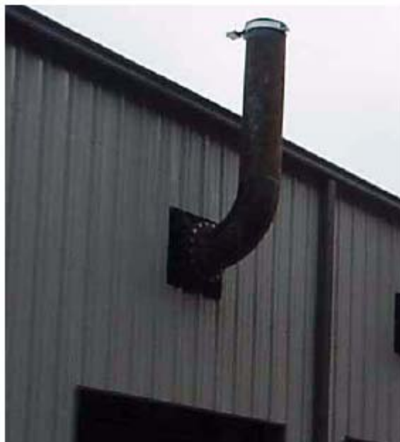
Рис. 6–9. Простая система выпуска с защитным колпаком от дождя и снега, не допускающим попадание влаги в выхлопной тракт двигателя.
